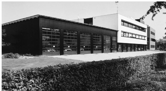
Brandweergarage in staalbouw
