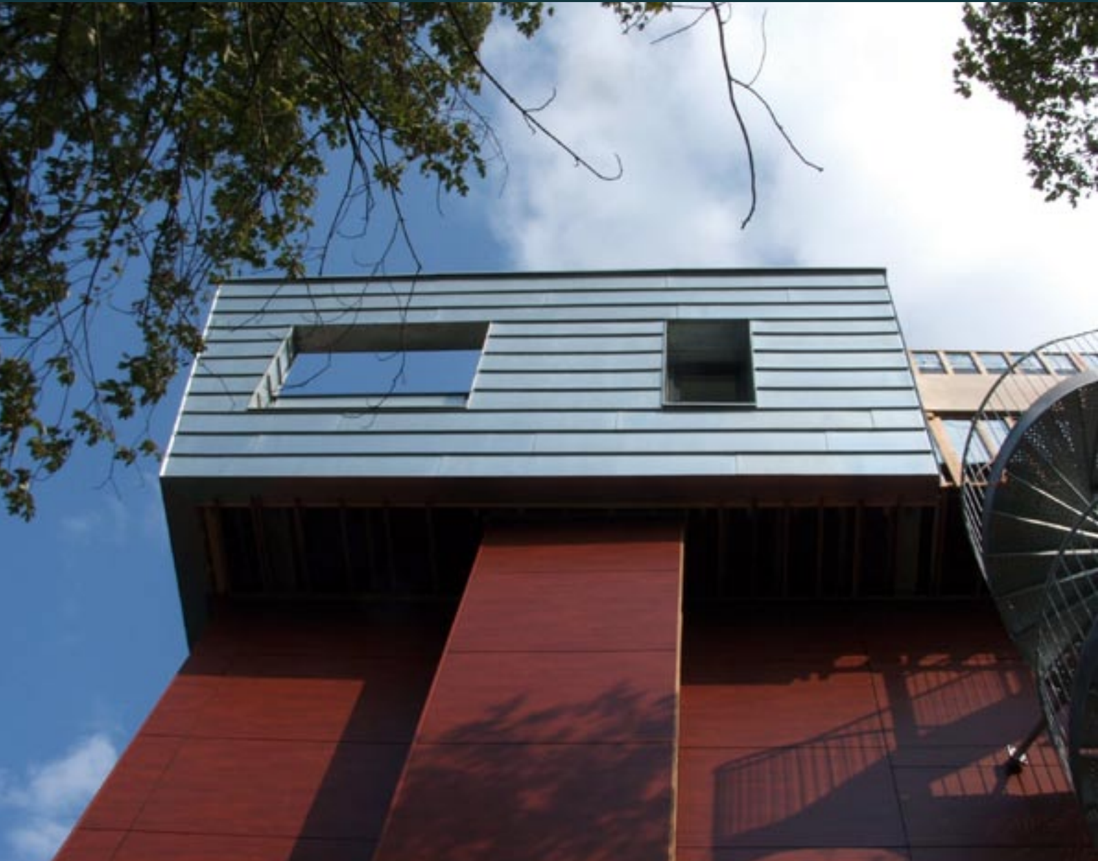
Herstructurering woonwijk Dalen, Rozenburg. Ontwerp: A3 Architecten, Rotterdam.
